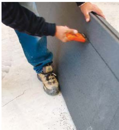
3 Tăierea panoului în corespondența profilului metalic
