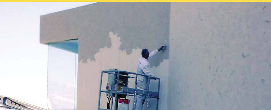
Finisajul peste izolație
