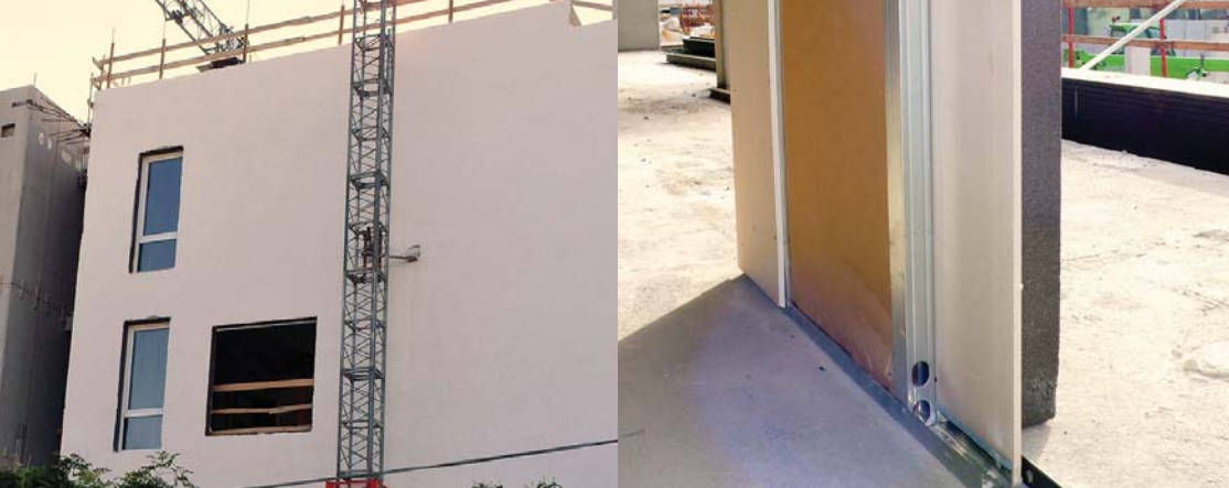
Finisaj exterior și cu izolați
