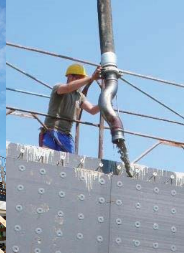
Turnarea cu pompa
