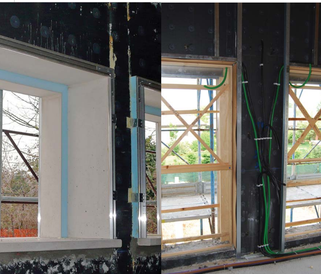
Prefabricat sub-gol așezat înainte de turnare
