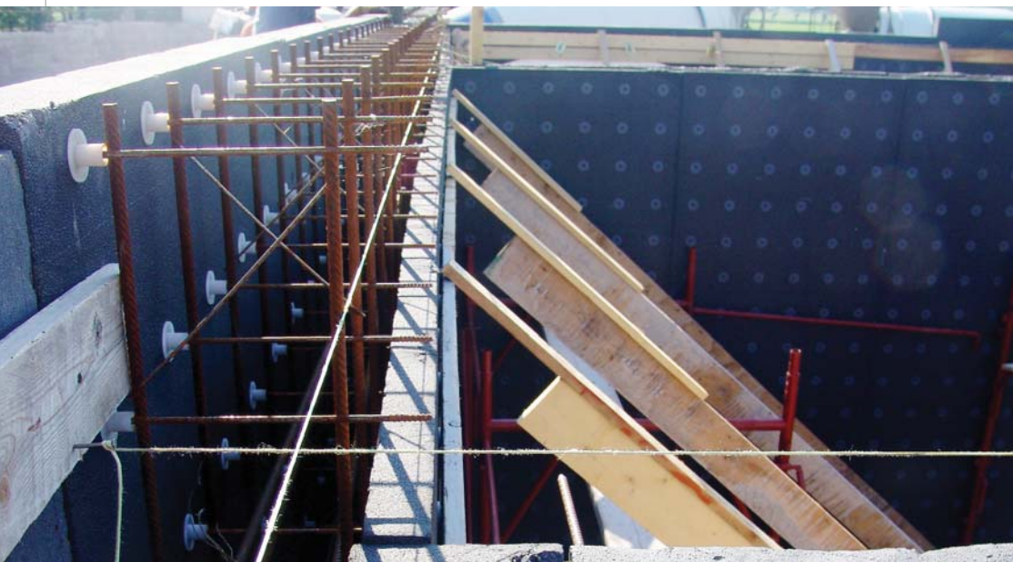
Detaliu al nervurii pentru rețeaua de podea
