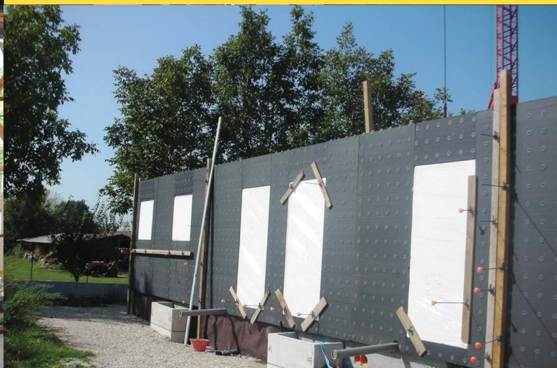
Montarea cofrajului cu închideri din blocuri EPS
